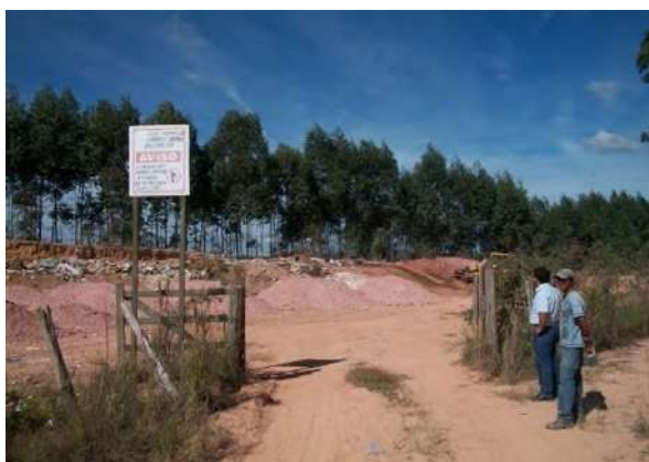
Figura 74: Entrada do Aterro Controlado.
