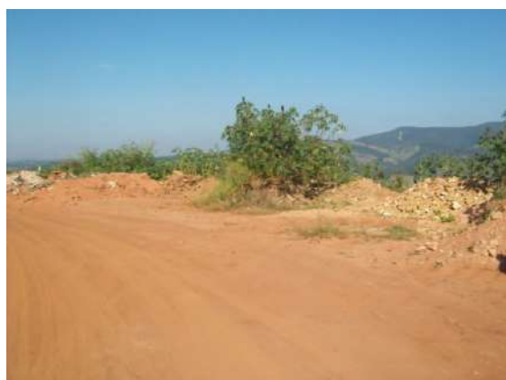
Figura 114: Ponto de descarte dos resíduos da construção civil.
