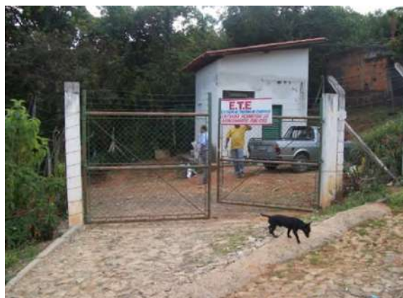
Figura 25: Entrada da ETE de Carandaí.
