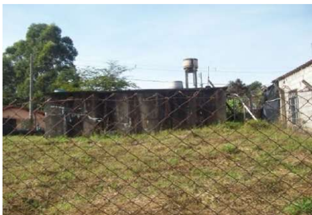
Figura 15: Reservatório para distribuição de água no município de Caranaíba.
