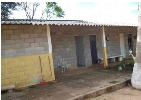
Figura 79: Unidade de apoio aos funcionários.
