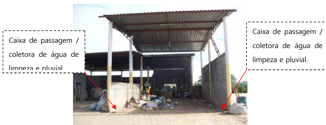
Figura 81: Área de recepção dos resíduos.
