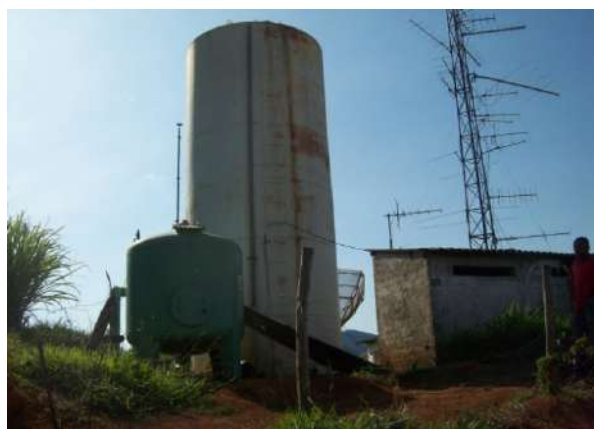
Figura 21: Reservatório de água do município de Santana dos Montes.
