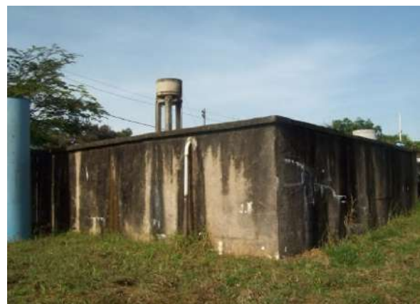
Figura 16: Reservatório de água no município de Caranaíba.
