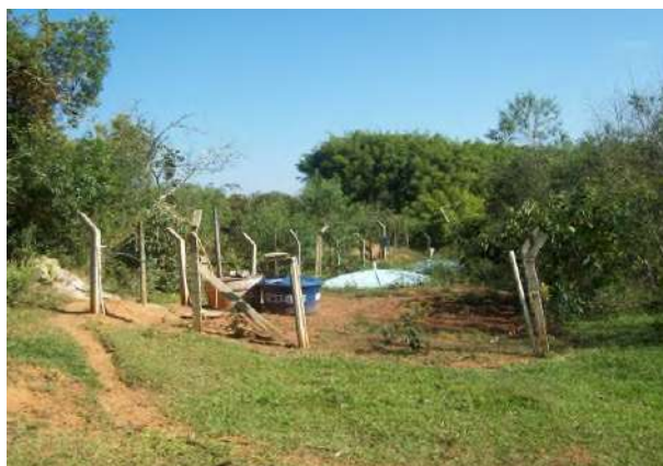
Figura 32: Vista geral da ETE de Queluzito.
