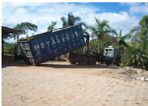
Figura 78: Vista do fim da via principal de acesso, sem pavimentação (cascalho) e início do pátio de manobra(bloquete).
