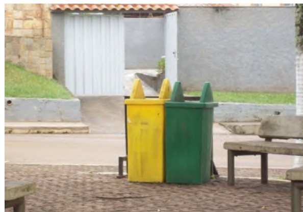
Figura 139: Coletores danificados instalados na Praça Marciano Vieira no Centro de Caranaíba.
