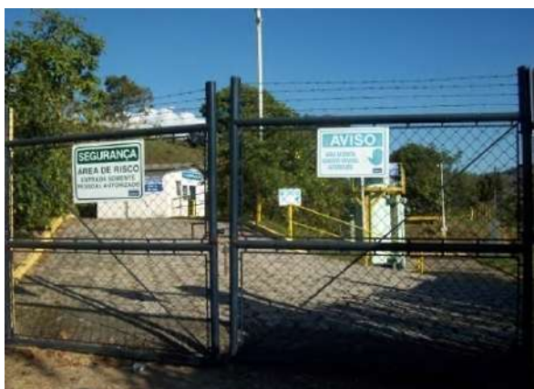
Figura 19: Portão de acesso a Estação de Tratamento de Água de Cristiano Otoni.
