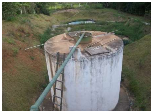
Figura 27: Reator UASB da ETE de Carandaí.
