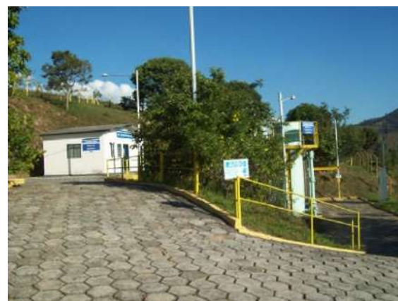
Figura 20: Estação de Tratamento de Água de Cristiano Otoni.
