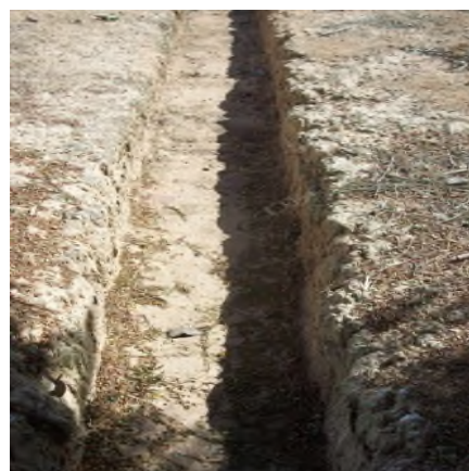
Figura 95: Canaletas de drenagem do pátio de compostagem sem o revestimento de concreto.
