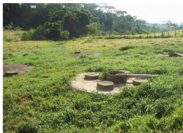
Figura 24: Vista geral da ETE de Caranaíba.
