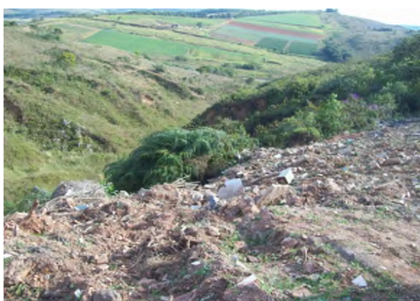
Figura 108: Ponto de descarte dos resíduos da construção civil.
